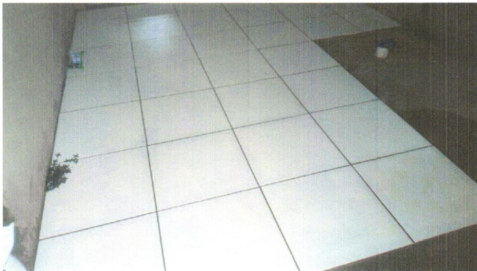
FOTO 9 - REVESTIMENTO CERÂMICO PARA PISO COM PLACAS TIPO ESMALTADA EXTRA DE DIMENSÕES 45X45 CM APLICADA EM AMBIENTES DE AREA MAIOR QUE 10M2 AF 06/2014
