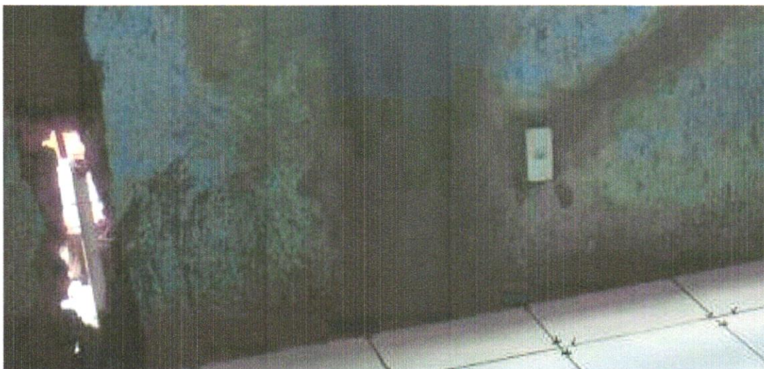
FOTO 03 - TOMADA BAIXA DE EMBUTIR (1 MÓDULO), 2P+T 10A , INCLUINDO SUPORTE E PLACA -FORNECIMENTO E INSTALAÇÃO
