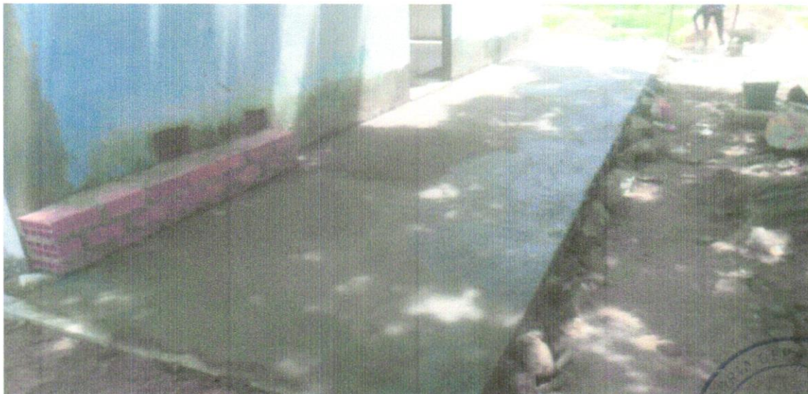
FOTO 11 – EXECUÇÃO DE PASSEI (CALÇADA) OU PISO DE CONCRETO COM CONCRETO MOLDADO IN LOCO, FEITO EM OBRA, ACABAMENTO CONVENCIONAL, ESPESSURA 8CM, ARMADO AF 07/216
