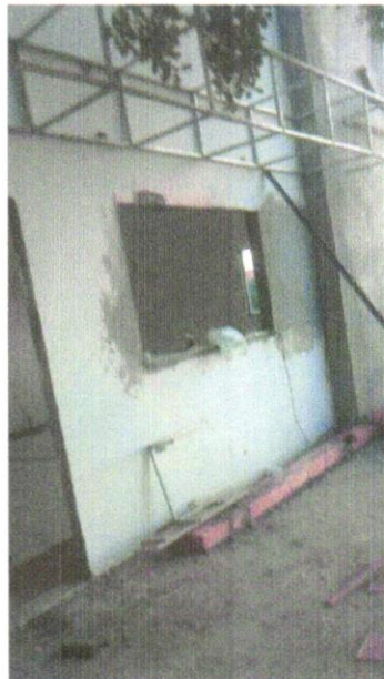
FOTO 08 - APLICAÇÃO E LOXAMENTO DE MASSA LATEX EM PAREDES, UMA DEMÃO.
