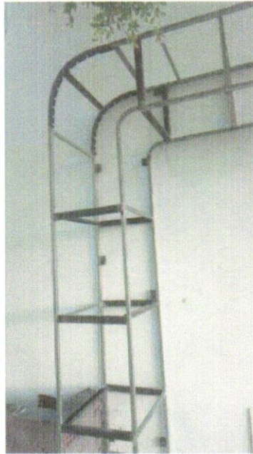
Foto 07- REVISTIMENTO METÁLICO EM ALUMÍNIO COMPOSTO (ALUCOBOND), E=03MM PINTURA KAYMA 500 COMPOSTA POR SEIS CAMADAS, INCLUSIVE ESTRUTURA METÁLICA AUXILIAR EM PERFIO DE VIRGA "U" DE 2 - FORNECIMENTO E INSTALAÇÃO
