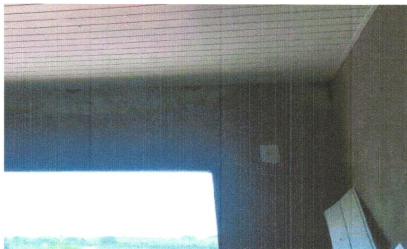
FOTO 02 – TOMADA ALTA DE EMBUTIR (1 MÓDULO), 2P+T 10A , INCLUINDO SUPORTE E PLACA -FORNECIMENTO E INSTALAÇÃO
